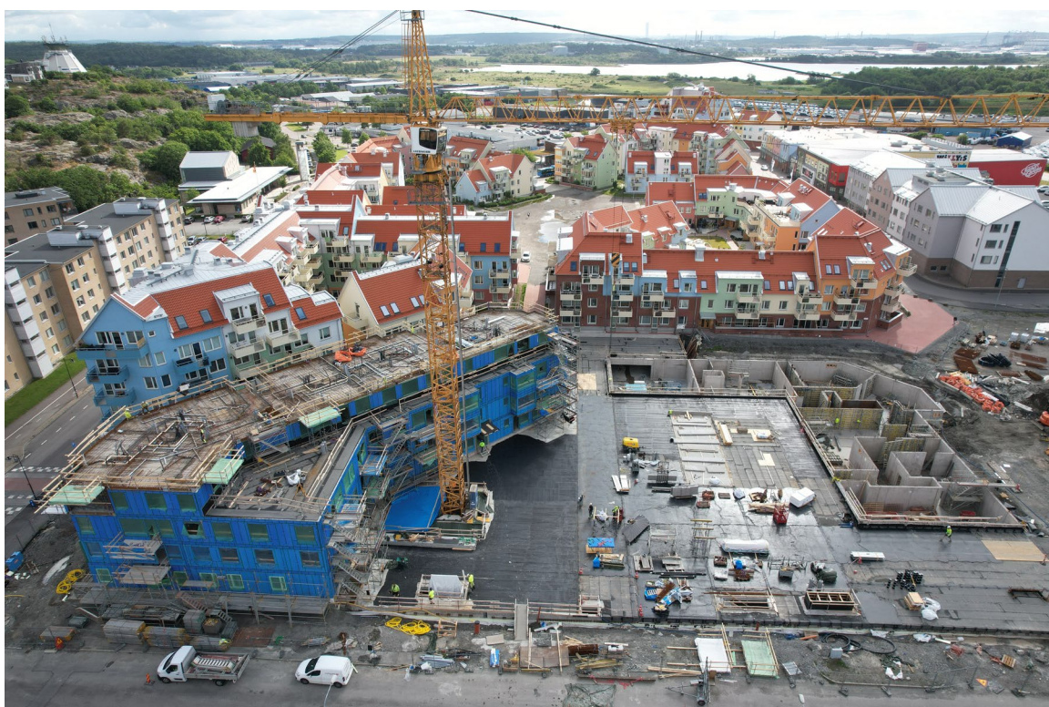
Figur 4: Foto över pågående byggnation inom planområdet (Amhult 2, 2024)
